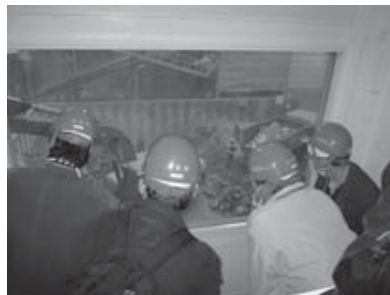
廃コンクリートプラント
