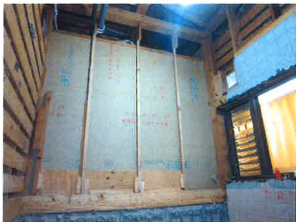
写真2 壁を削った後
