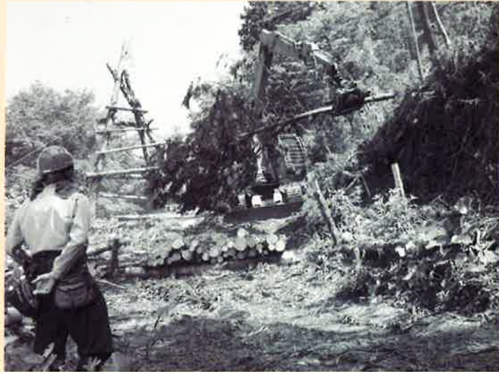
杉の木の伐採現場です。
