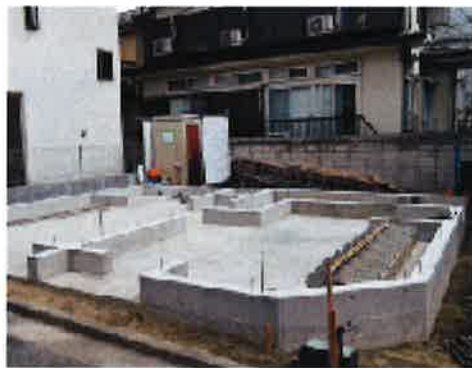
基礎工事完了
