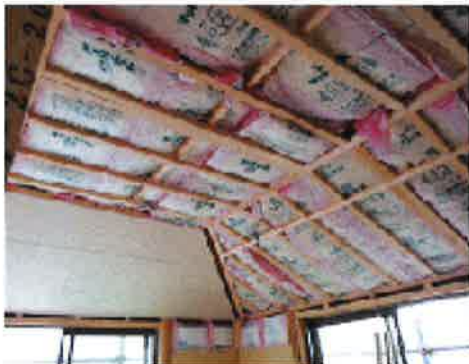
3階 天井裏グラスウール系断熱材
