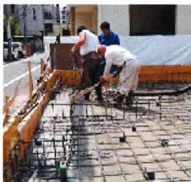
コンクリート打設作業
