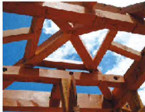
3階 小屋組み棟合掌部
