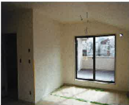
内装仕上げ過程
