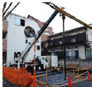
地盤補強のための鋼管杭打ち
