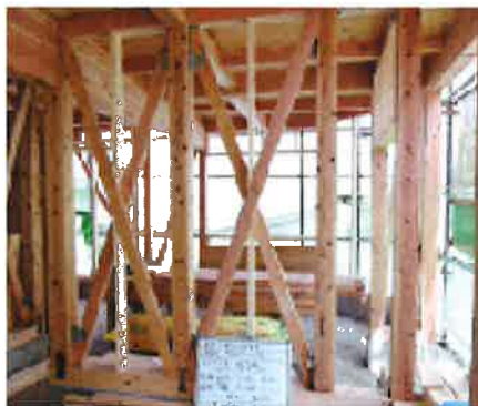
1階 筋違による耐力壁補強
