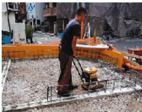
埋戻し碎石作業
