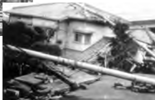
古い構法による建物
