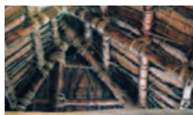
かやぶきの里の天井
