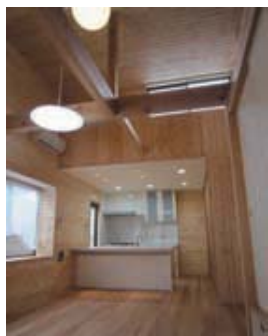
▲壁、天井にパイン材。床は杉材
