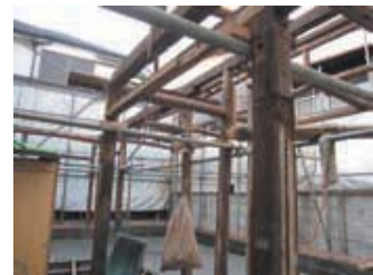
▲既存の柱を残した状態 (工事中)
