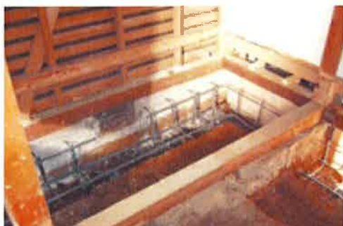
(基礎補強工事)
