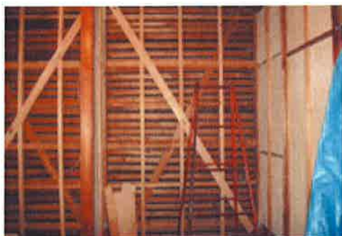
(内壁補強工事)
