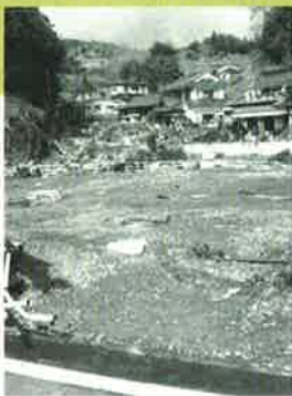
作業所・自宅流出跡
